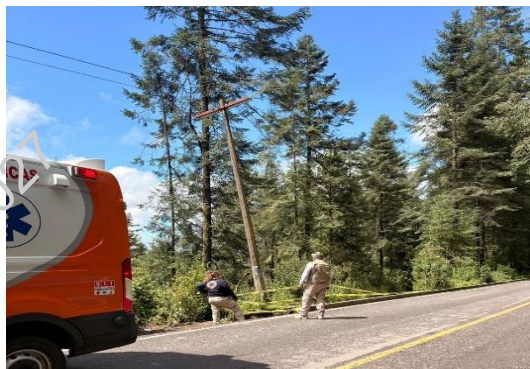
Ilustración prevención de un poste de electricidad apuntó de colapsar.
